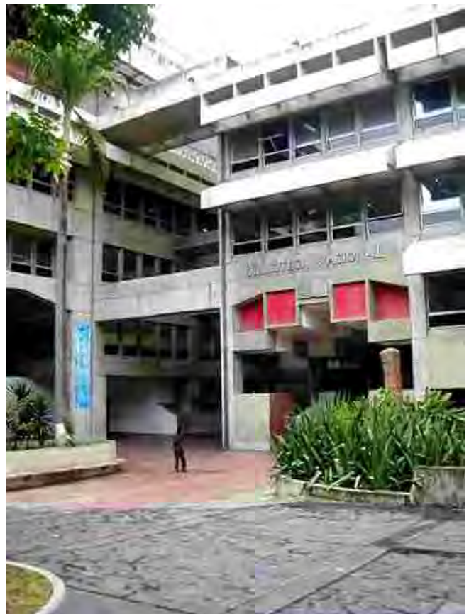
Biblioteca Nacional. [Edificio sede, 1989]. Caracas: Parroquia Altagracia, Final Avenida Panteón, Foro Libertador.
